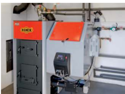
Vzorová kotelna s kotlem ROJEK TKA 25
