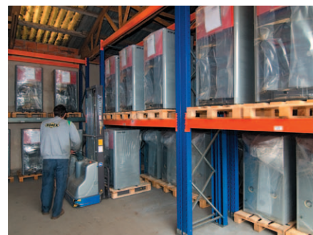
Automatizovaný systém skladovania
